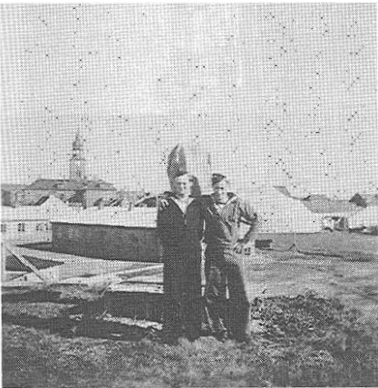
Dette billede er taget fra kystudkigshøjen. Forreste bygning var mand-skabsbygning. Bygningen til venstre var administrationsbygning samt beboelse for chef og næstkommanderen. Læg mærke til, at der var cirkusplads ved siden af til højre.
