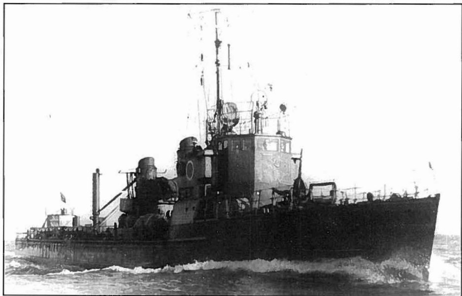
HVALEN i tysk tjeneste under navnet TFA 5. TFA stod for Torpedofangboot Ausland. Bemærk kranen på agterdækket, der blev brugt til indtagning af torpedoer.
