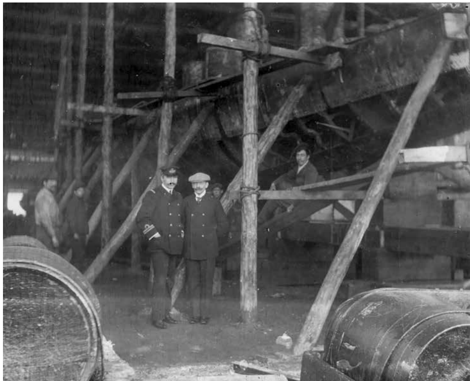
Så vidt vides det eneste kendte billede af DYKKEREN under bygning i Spezia (Italien) i januar 1909. Danmarks næste tre ubåde af A-klassen blev bygget i Fiume/Østrig, hvorefter Orlogsværftet havde lurt italienerne og østrigerne kunsten af. (Ole. H. Quaade/ Tom Wismanns arkiv)
