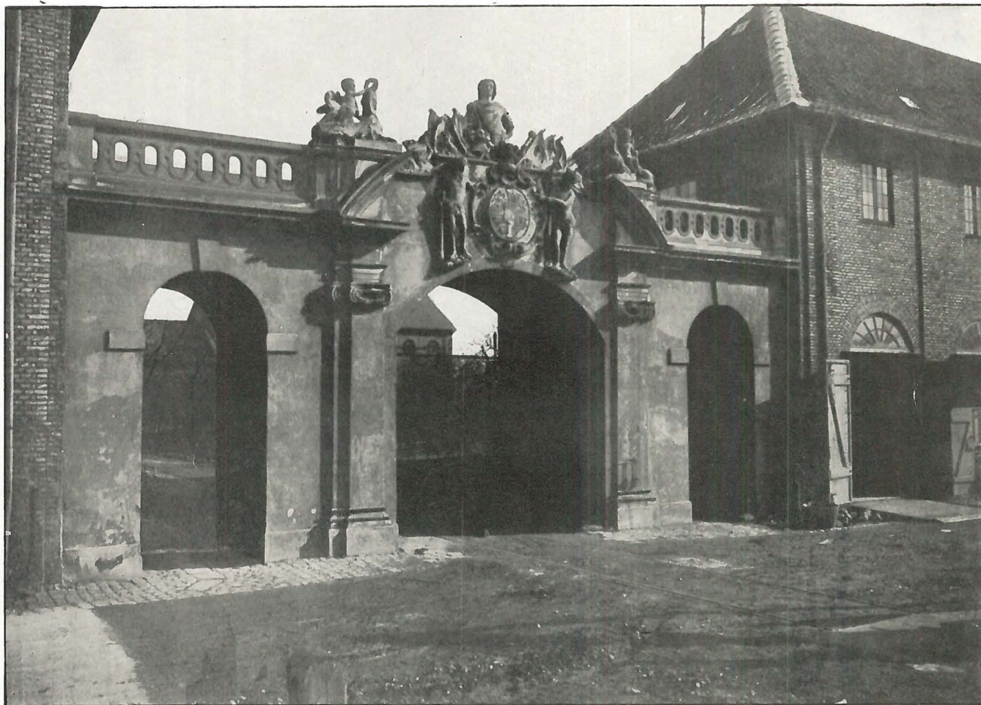
Porten i Arsenalbygningen.
