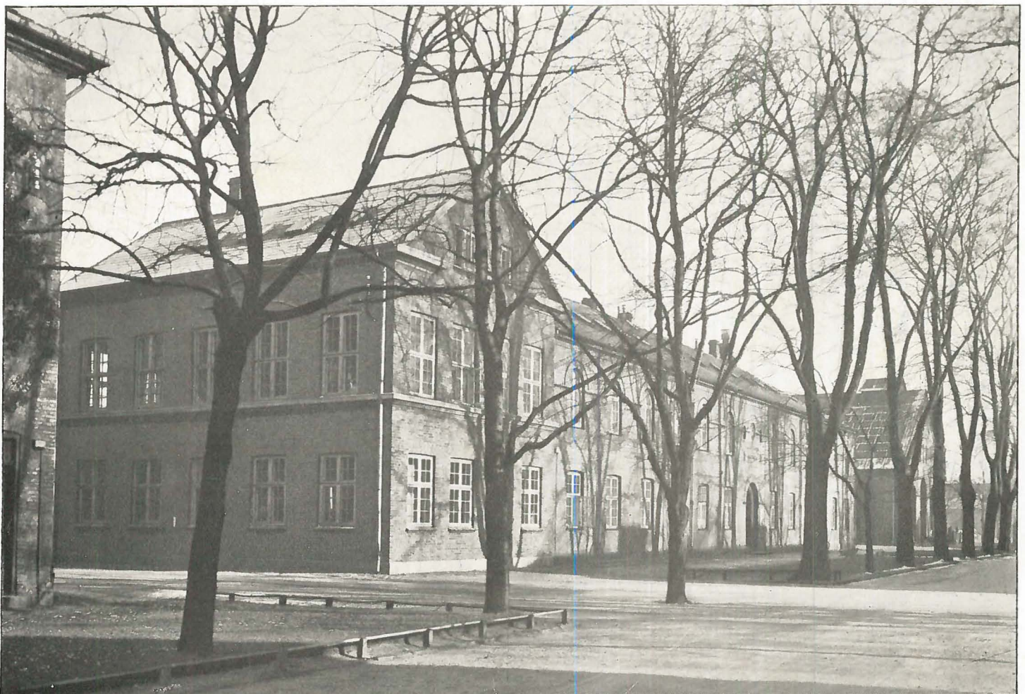
Fot. „Før og Nu“ ved Elfelt. 1924.
