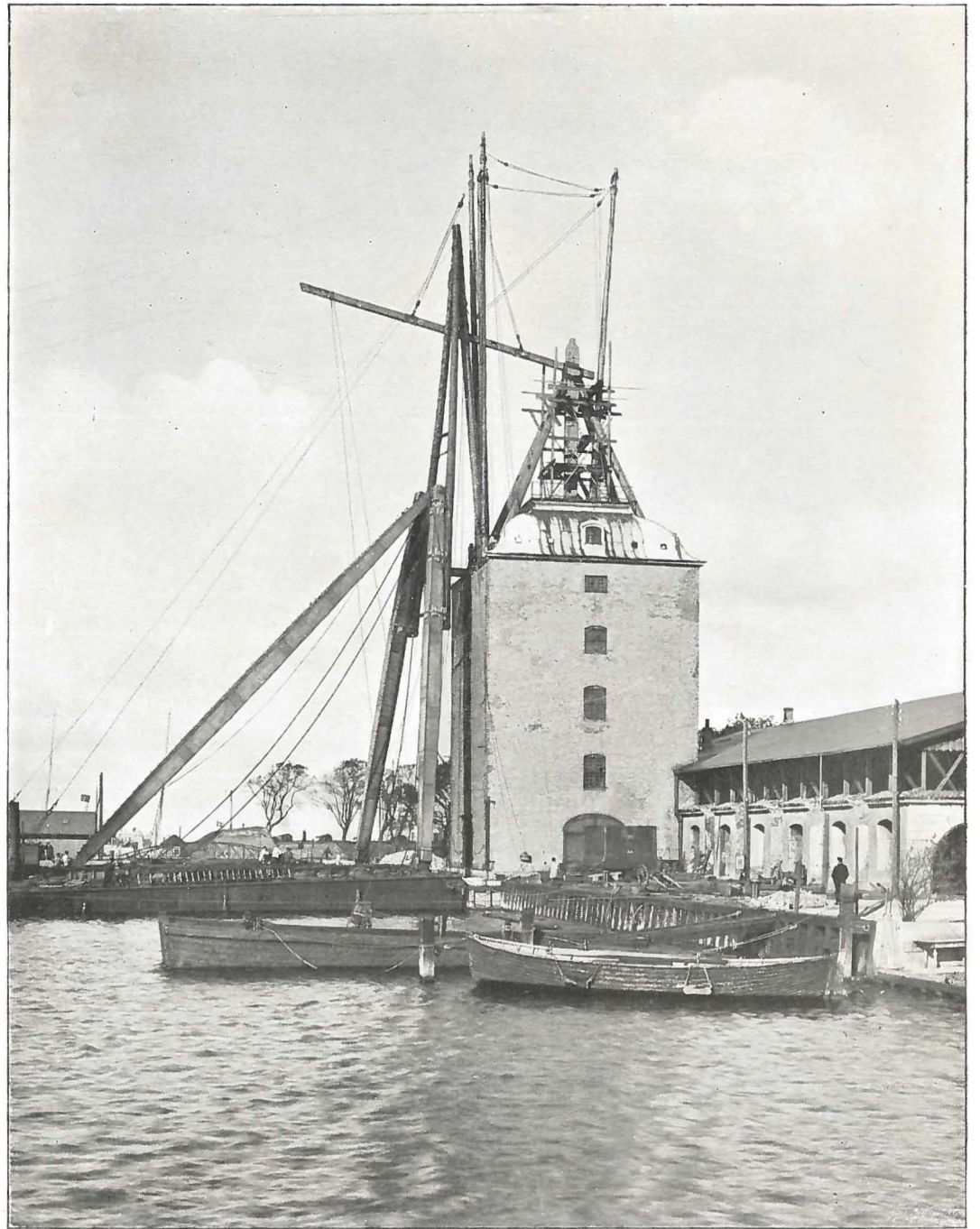
Nyholms Krans Hovedreparation, 1922. Den flydende Kran anbringer den første Hovedbjælke paa Kranens Top.
