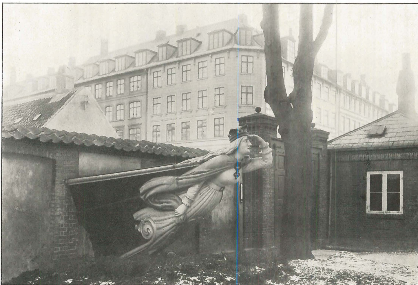
Fot. „Før og Nu“ ved Elfelt. 1924.
