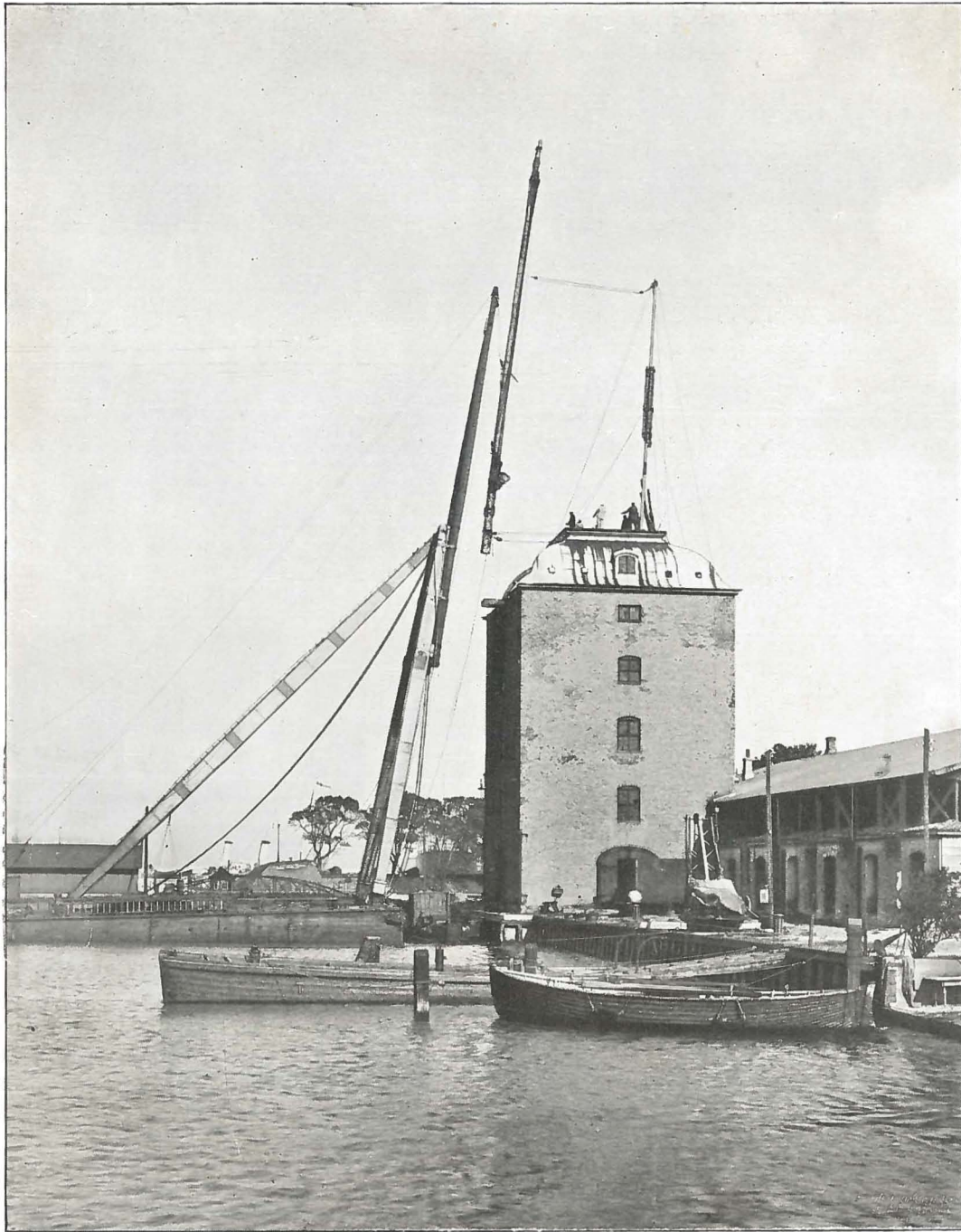
Nyholms Krans Hovedreparation, 1922. Den flydende Kran med Forlængelsesben aubringer Rejsebuk paa Kranens Top.
