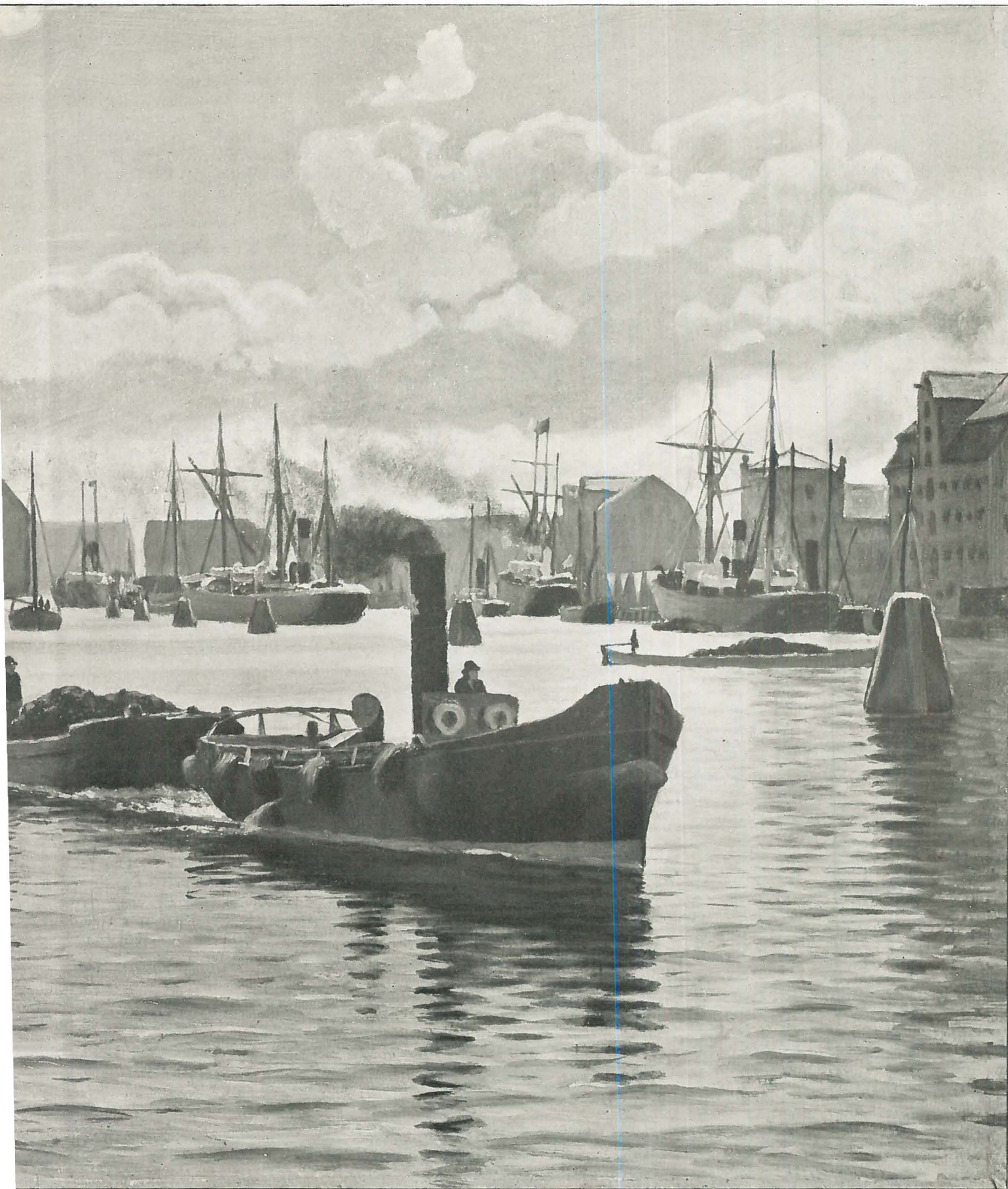
venstre ses et Stykke af Hønsbroen.
