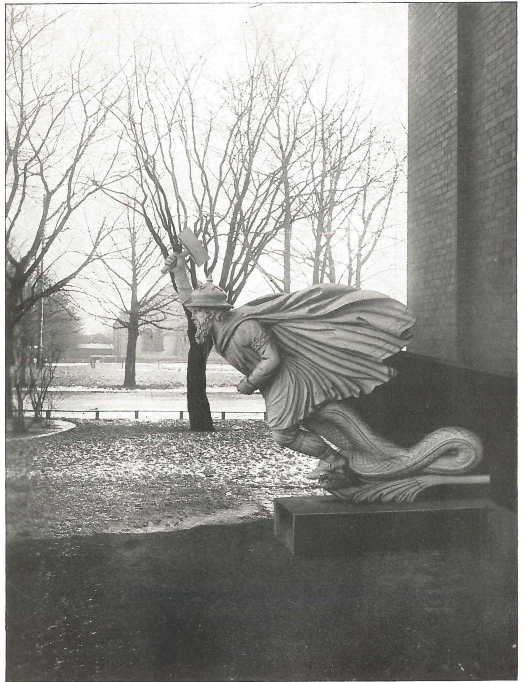
Fot. „Før og Nu“ ved Elfelt. 1924.
