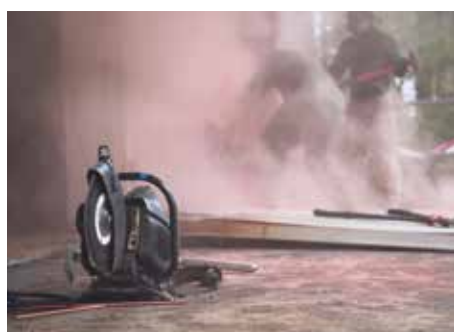
Med en kraftig benzindrevet vinkelsliber skæres snit i murværket, inden det bankes ind med en stor klaphammer. Det tager ikke mange minutter, men den bagvedliggende betonvæg overgiver sig ikke.
