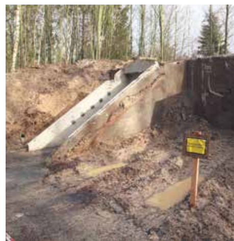
Første skridt i nedrivningen er at rense bunkeren indvendigt og grave den fri af det overliggende jordlag.
