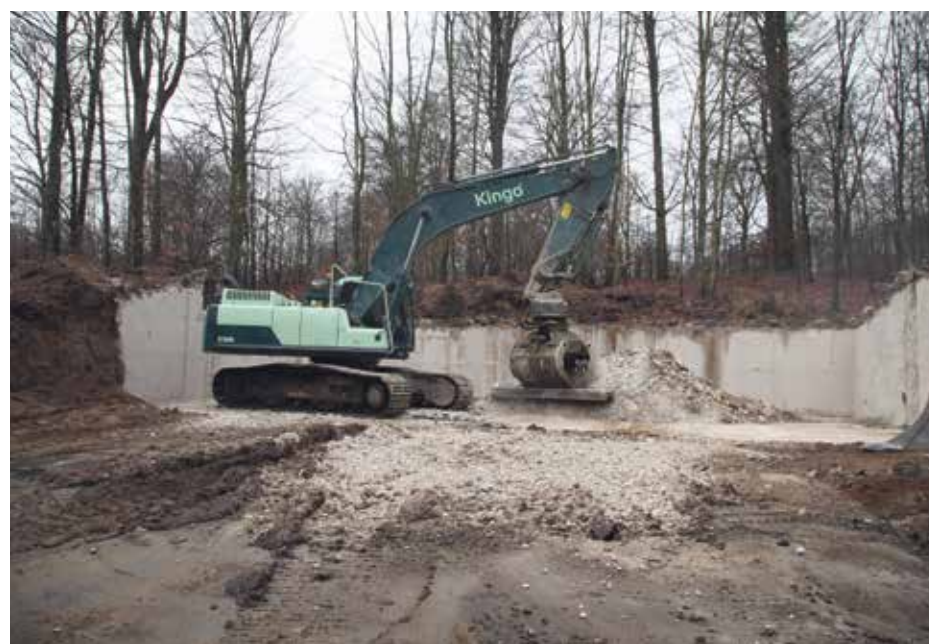
Med hydrauliske klør klippes bunkerne i stykker. Stykkerne køres væk, og jern sorteres fra, og betonen knuses til mindre stykker.
