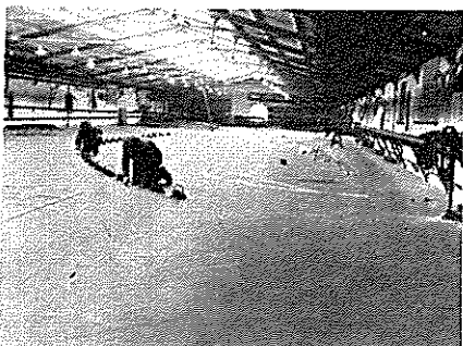
Afslagningsløftet, hvor skibets form optegnes i naturlig størrelse. Som kurvelineal benyttes bøjelige stokke, der fastholdes i formen med lodder. På gulvet ses endvidere træskabeloner.
