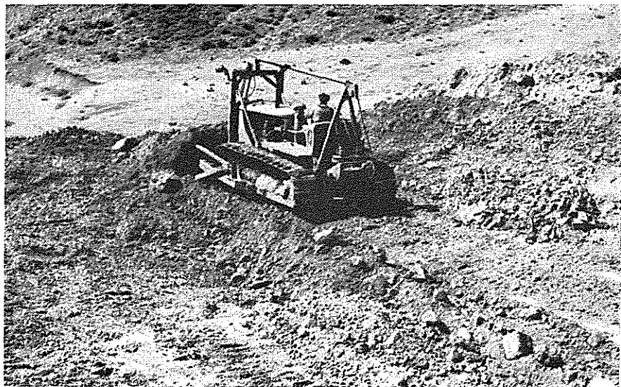
Amerikansk Bulldozer på vejarbejde.
