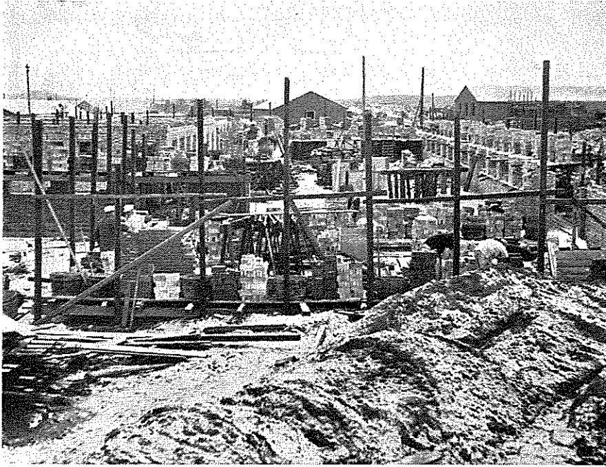
Opførelsen af Kommandobygningen er i gang i Sjælsmark.
