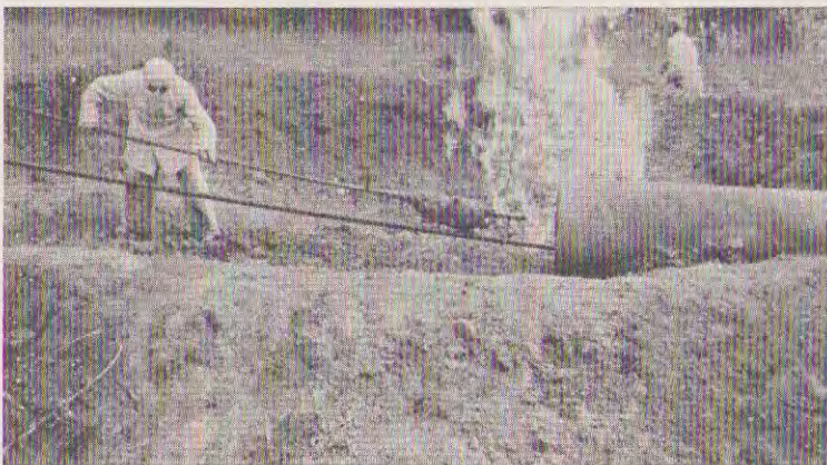
Reparation af Gasledning.
