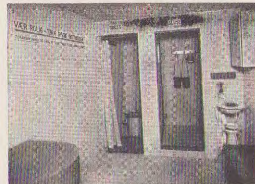
Beskyttelsesrum med Gasluse og Toilet.
