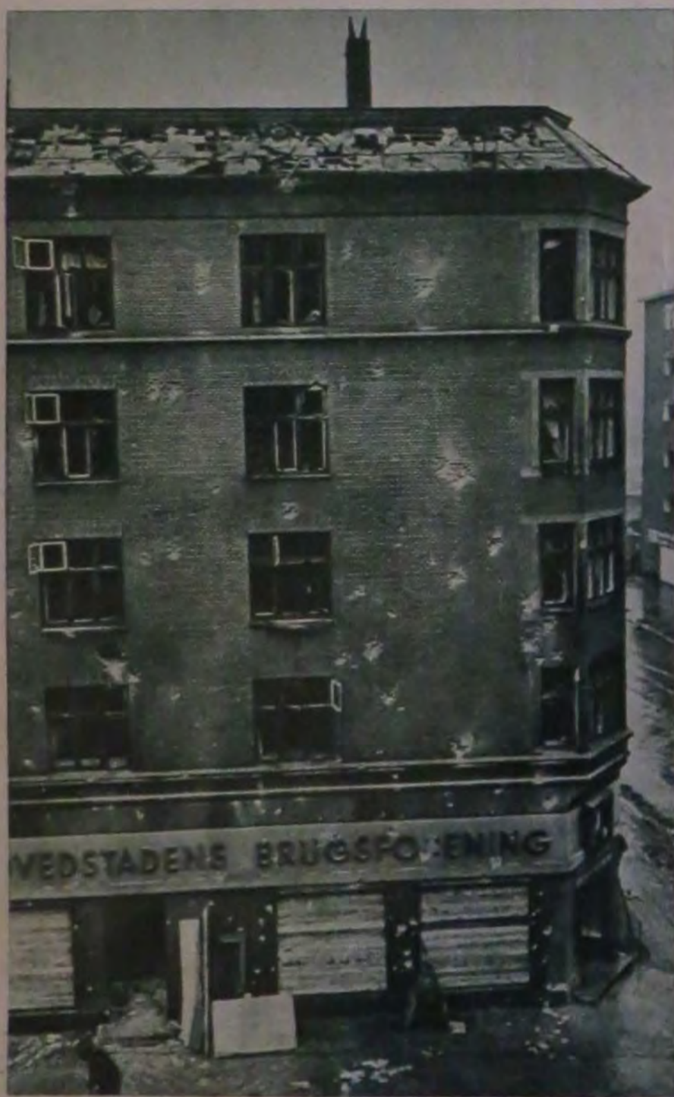
Bygning i Njalsgade i København efter Bombenedkastningen den 27. Januar 1943. Læg Mærke til, hvor Facaden er gennemhullet som en Si af talrige Sprængstykker efter den 225 kg Bombe, der eksploderede midt i Gaden
