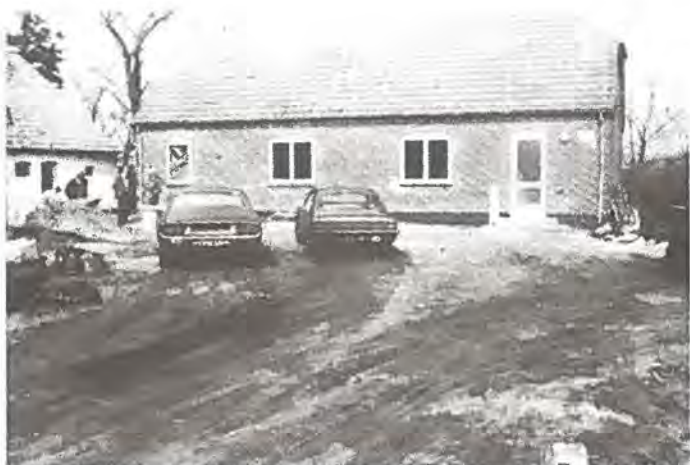
Fra starten på arbejdet, hvor vejret var fint. DEC 1978.
