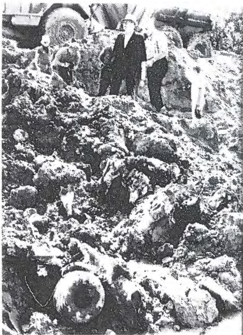
Fra udgravningen. I Forgrunden Elyets halehjul.
