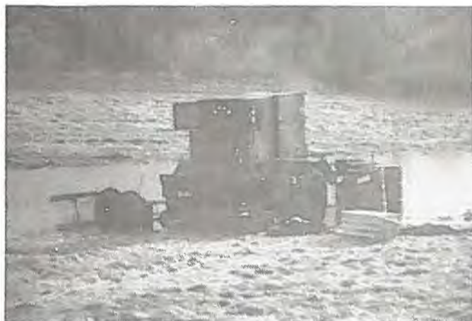
Generatorer placeres lavt, i vort tilfælde for lavt, ihvertfald i regnvejr.
