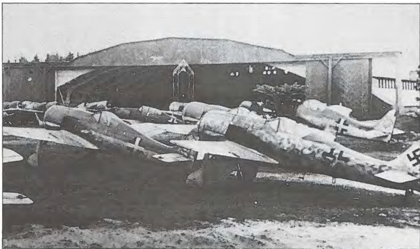
Billedet viser størstedelen af de Focke-Wulf Fw 190-jagere det tyske Luftwaffe efterlod på Vandel flyveplads i maj 1945. Midt i billedet ses en kran, som anvendtes ved skift af motorer på flyene. Hangaren i baggrunden er bygget af Luftwaffe, en såkaldt Lagerhalle Typ 241 d, Delta Flugzeughalle..... Hangaren nedbrændte i 1968.
