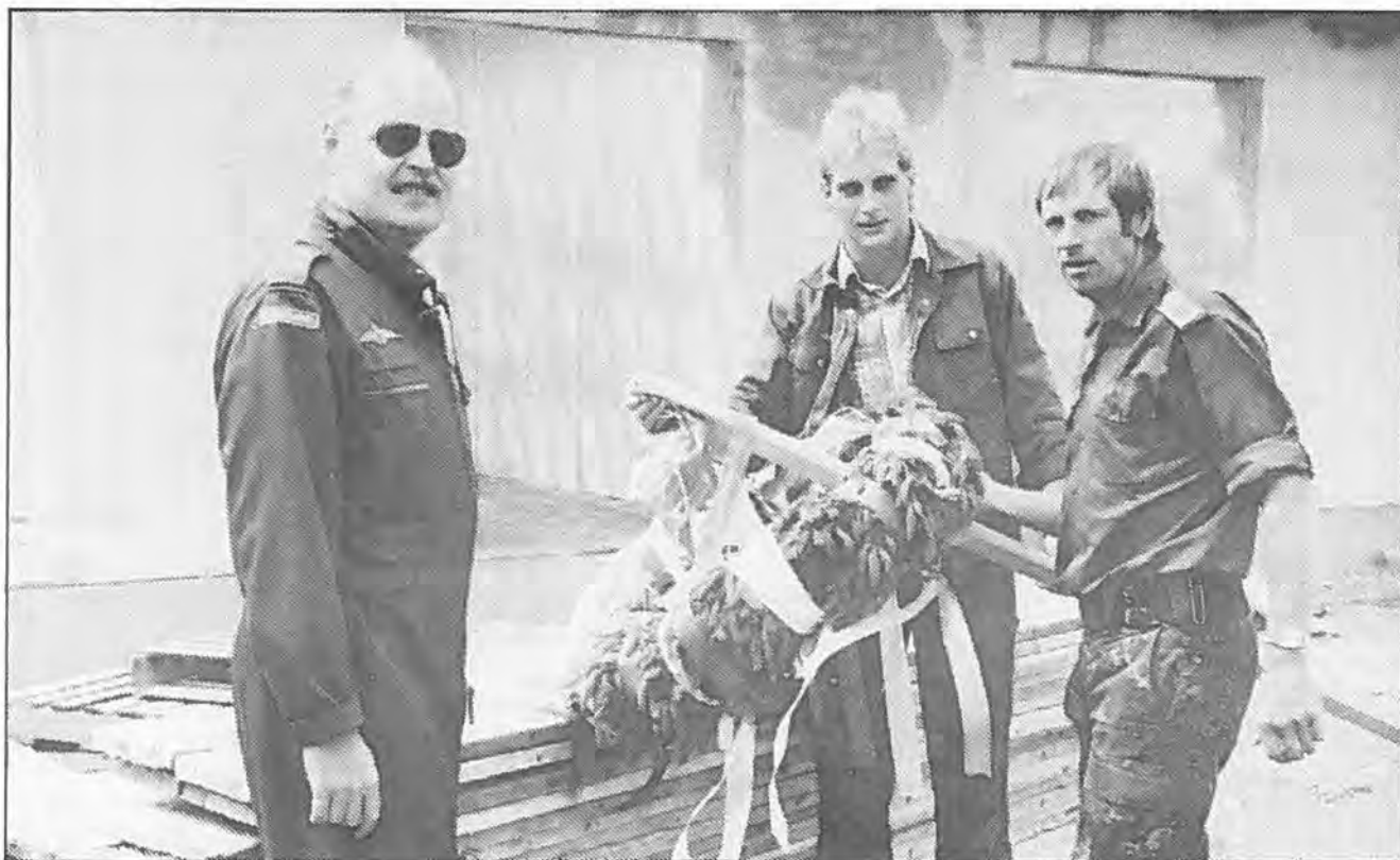
Hærens Flyvetjeneste ønskede også at fejre den nye bygning. Fra v. Chefen for Hærens Flyvetjeneste oberstløjtnant E. Bagge, en tømrer og seniorsergent Laursen. Et øjeblik efter var alle tre oppe på taget for at gøre rejsekransen fast. (foto s-n)
