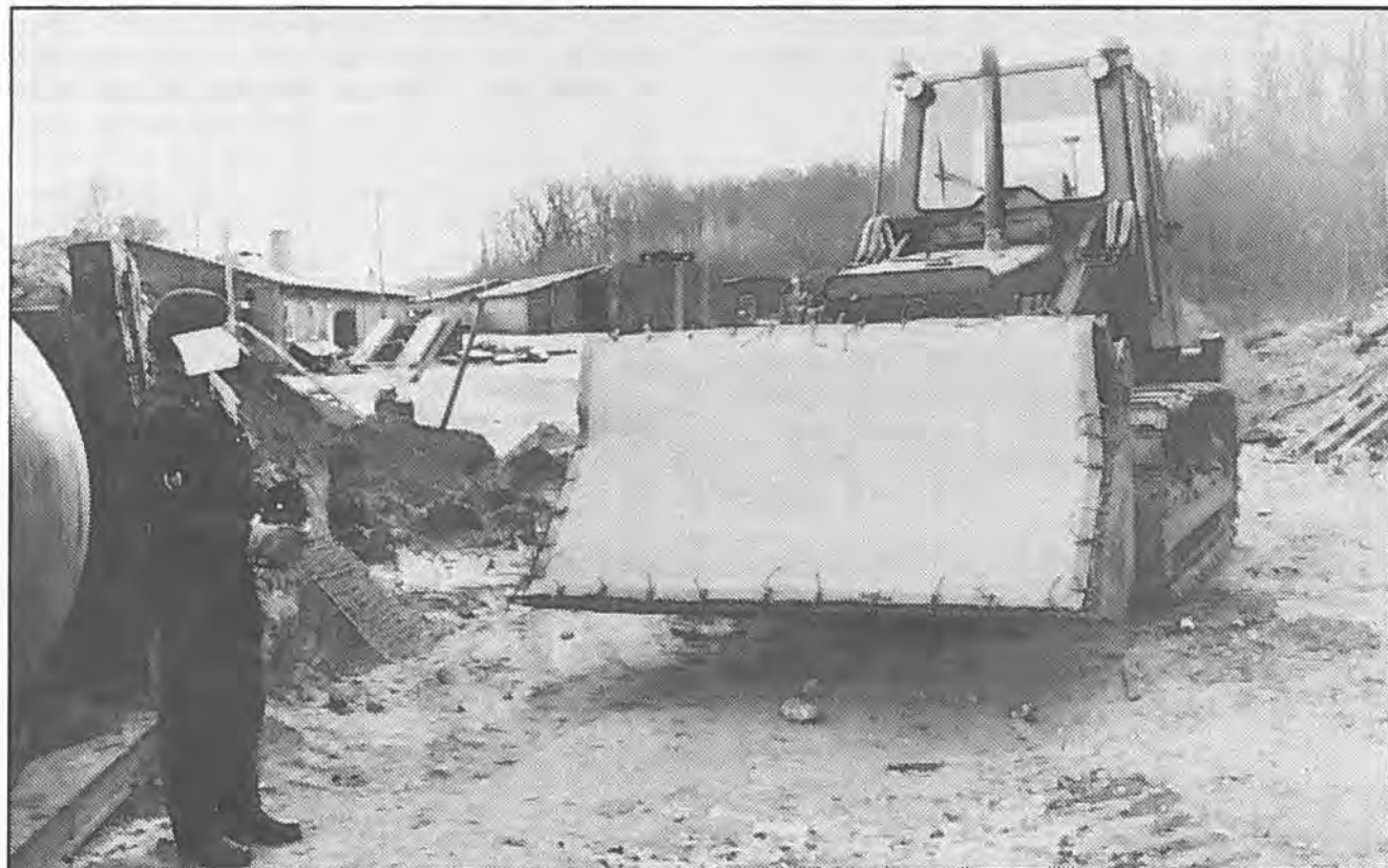
Traxcavator ("Rullemaries" storebror) er klargjort med sprængmätte.
