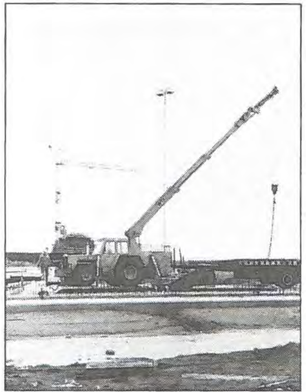
Beton og kraner sammen med rundjern synes at være hovedingredienserne på byggepladsen. Vinteren igennem brændte der lys fra tidlig morgen til sen aften. Nu er det heldigvis forår og ind imellem kan man godt blive lidt misundelig på de der arbejder udendørs - sådan var det ikke i vinter.
