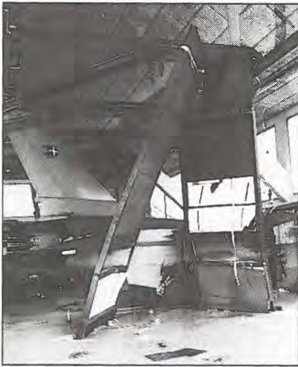
Oprydningen er igang, portelementerne sikret og kranen trukket ud.
