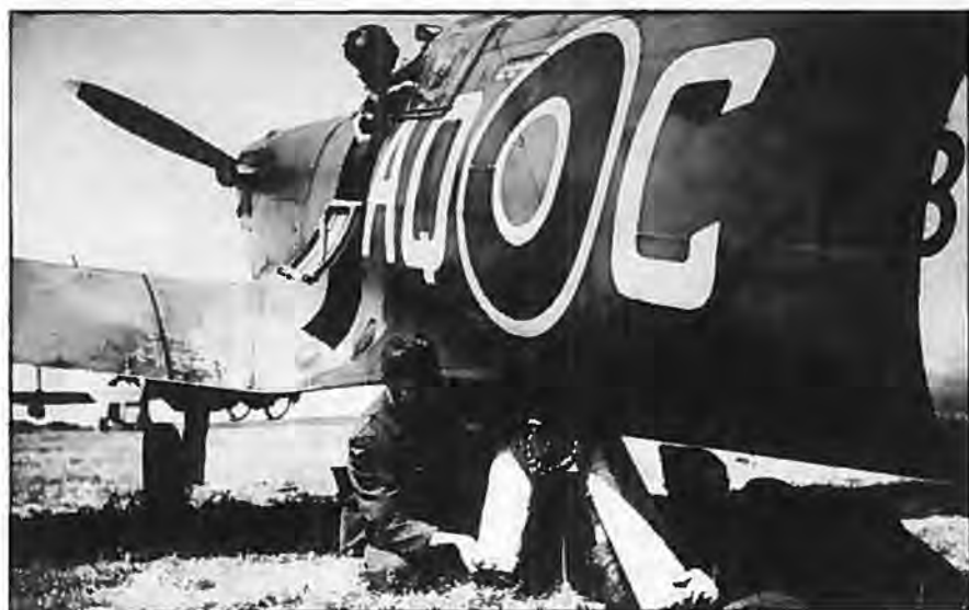
Her Supermarine Spitfire i en usædvanlig rolle, som air-sea redningsfly. Flyet her er en Spitfire ASR Mk.IIC fra 276 Sqn. Det bliver lastet med to beholdere. Den ene indeholder en lille dinghy (gummibåd) og den anden mad og overlevelsesudstyr. Piloten kunne, når han opdagede en nødstedt kollega på havet, droppe de to beholdere i nærheden af ham.
