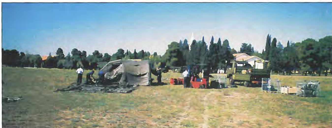
'Teltholderforeningen', eller Eskadrille 730's personel i gang med at rejse det første telt på den bare mark. At stille et telt op ved hjælp af trykluft går noget hurtigere end det gamle system med bræddegulv og aluminiumsstænger.
