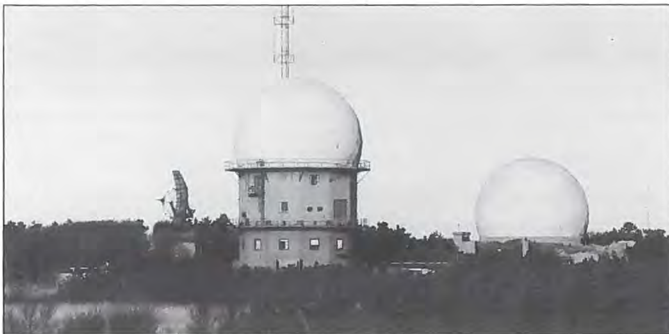
Radarstationen på Skagen i klar vintersol, præcis den 29. januar 1997. Til venstre ses højdefinderens antenne og i midten tårnet med, radarantennen, som er dækket af radomen (kupler).
