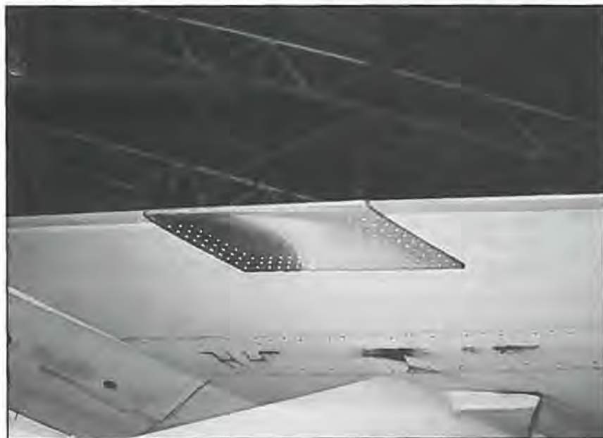
Så nydeligt ser det ud, når ABDR-folkene (Luftkampskadereparationsfolkene) har lavet en foreløbig reparation, der kan holde fra Portugal til Flyvestation Alborg.
