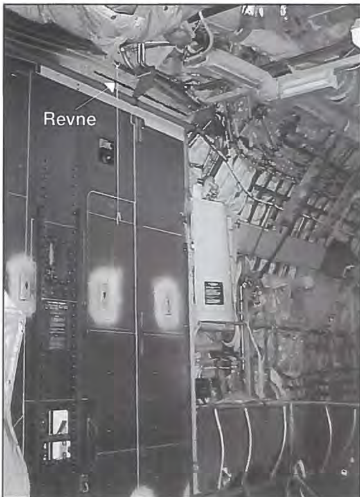
Den bærende Web (bjælke eller rib) som revnen opstod i ses øverst i billedet ved pilen.
