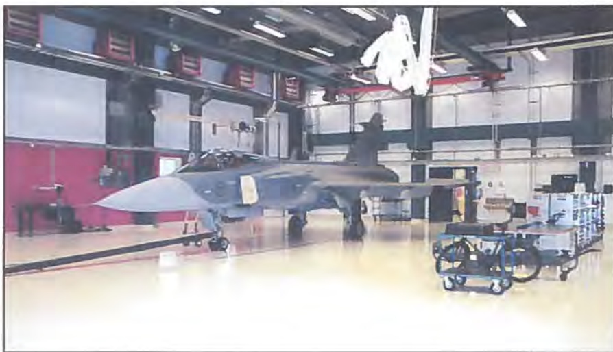
Sveriges stolthed JAS-39 Gripen i den nye hangar på Ängelholm. Her er alle de hjælpemidler en flymekaniker kan drømme om, når fly skal vedligeholdes. De røde kasser oppe under loftet er „dyser“, der producerer let skum, så hangaren i løbet af tre til fire minutter fyldt med skum.
