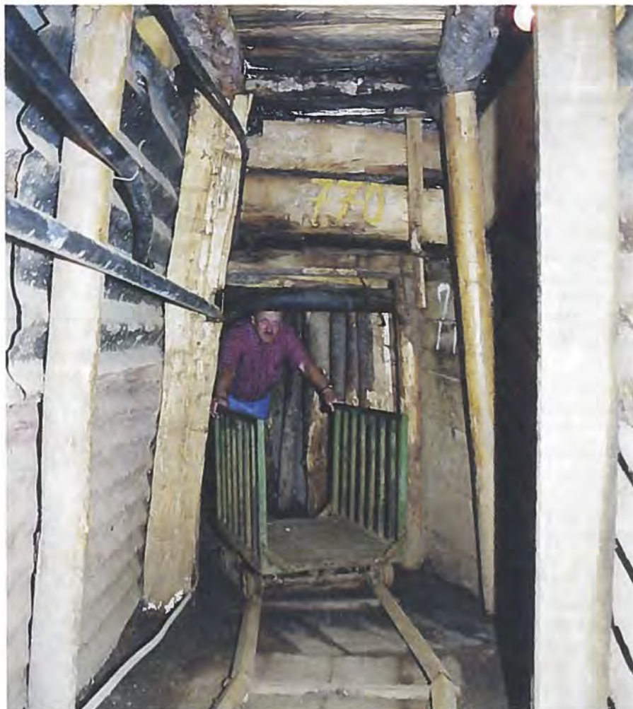
Tunnelen, der førte under startbanen på Sarajevos lufthavn var 800 m lang, som det ses, meget snæver. Alle forsyninger til byen, og de sårede fra frontlinen 400 m fra indgangen blev kørt-skubbet til byen på den trækvogn, der ses i baggrunden.
