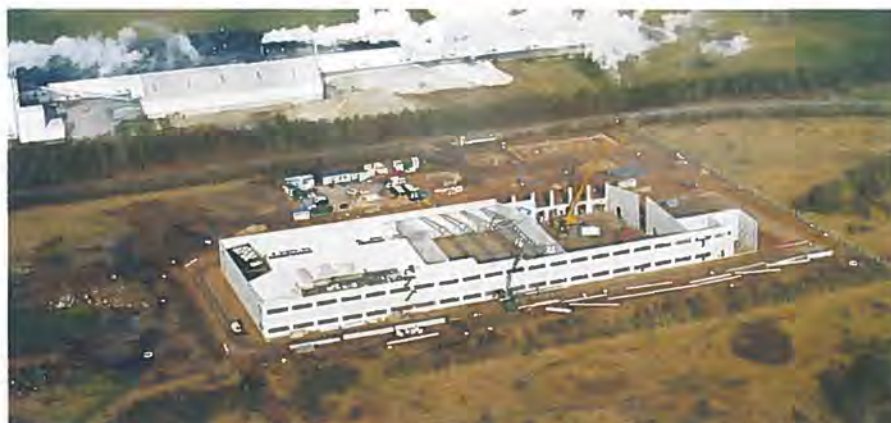
Det nye hoveddepot under opførelse på grunden Lilholtvej 4b, Flyvestation Skrydstrup.
