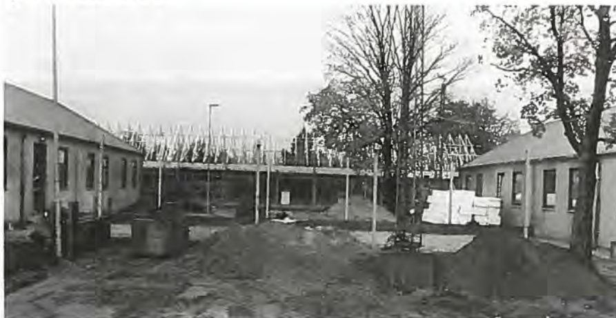
Et kig ned mellem to af Flyvevåbnets Førings- og Operationsstøtteskoles bygninger, hvor en mellembygning er under opførelse, en del af de 600 m 2 man kommer til at råde over fra den 17. januar næste år, hvis ellers vejret arter sig.
