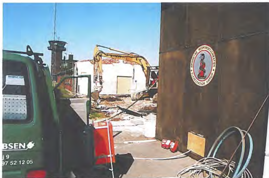
Brand- og Redningstjenestens nye crashtenders er for høje til at komme ind i de gamle garager; derfor skal der bygges nyt mellem administrationsbygningen og den gamle garage.
