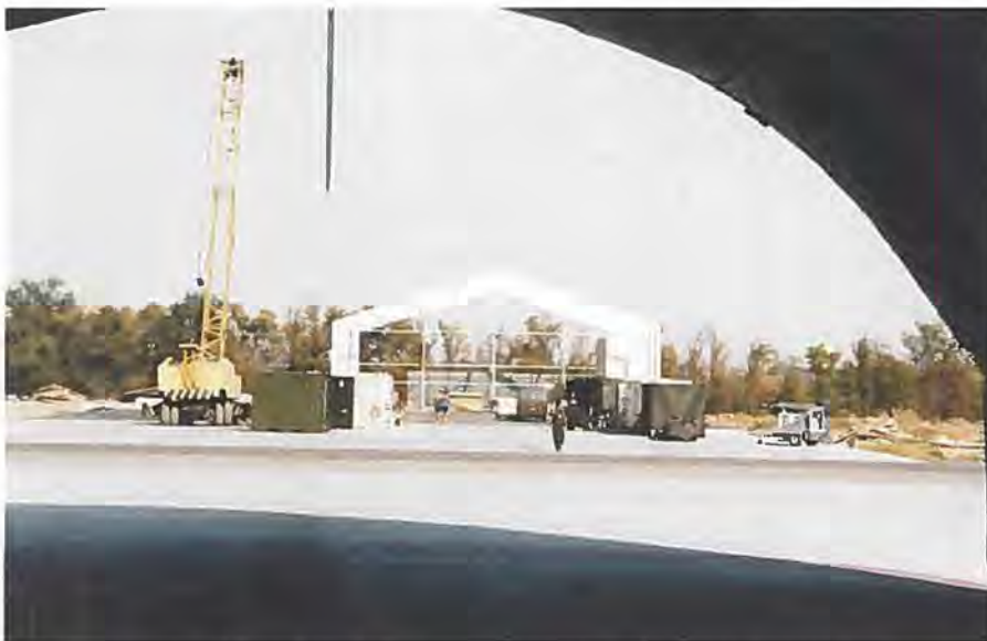
Felthangaren under opførelse. Som man kan se, er der containere i to etager. De skal indeholde specialværksteder, kontorer og opholdslokaler. At containere blev sat op først, forklarede med, at „teltstænger“ og teldug var forsinket, og ud fra devisen: „Er det der ikke som skal bruges, laver vi noget andet“, og sådan var det.
