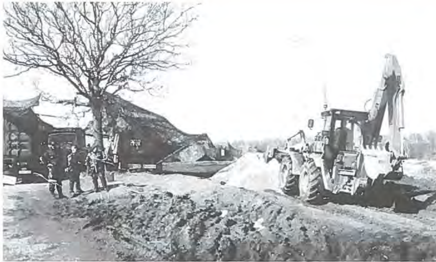
I nøden skal man kende sine venner. Her er det en gummiged fra Ingeniørtrupperne, der er i gang med at lægge stabilgrus ud. I løbet af et par timer var et pløret spor ændret til en fin grusvej.
