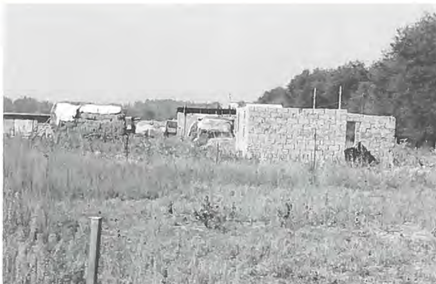
Nybyggeri i landsbyen „Big Brother”. Huset nærmest kameraet er opført af solbrændte lersten. Beboelseshuset i baggrunden er derimod opført af brændte mursten.
