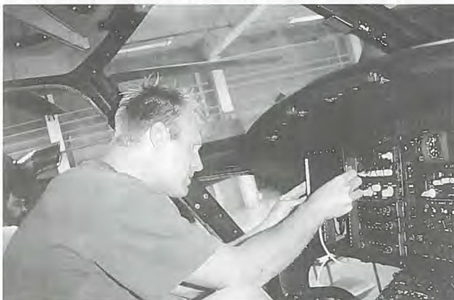
Pladesmeden i færd med at montere GPS'en i konsollen i cockpittets venstre side.
