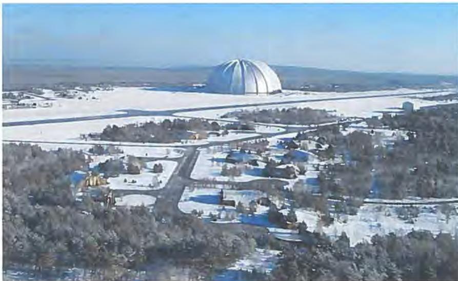
Den gamle russiske flyvestation i Briesen-Brand ca. 60 km syd for Berlin i delstaten Brandenburg. Banesystemet er stadig intakt, medens eskadrilleområderne er på vej mod ruin. (Billede CargoLifter).
