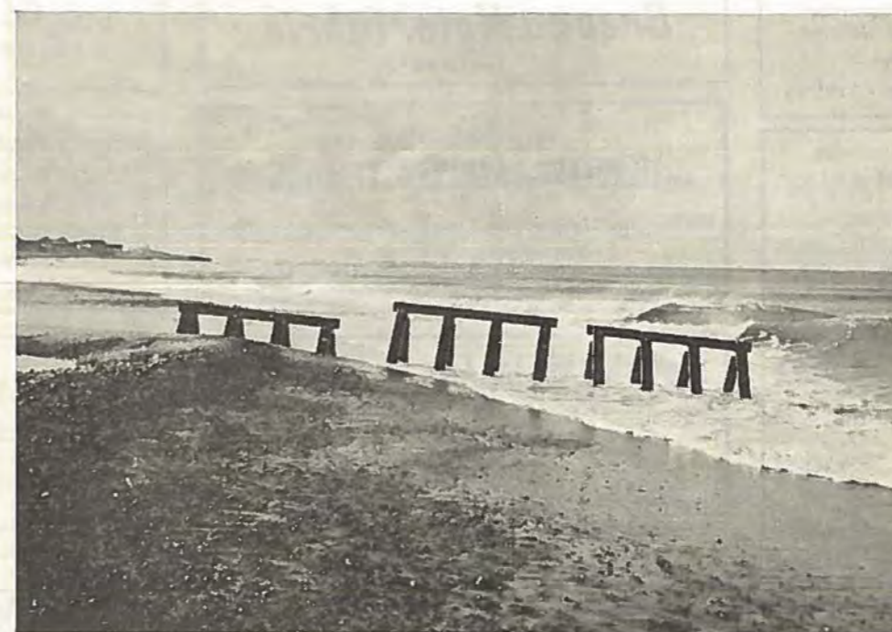
Kystsikring paa en ny maade ved Klitmøller . .
