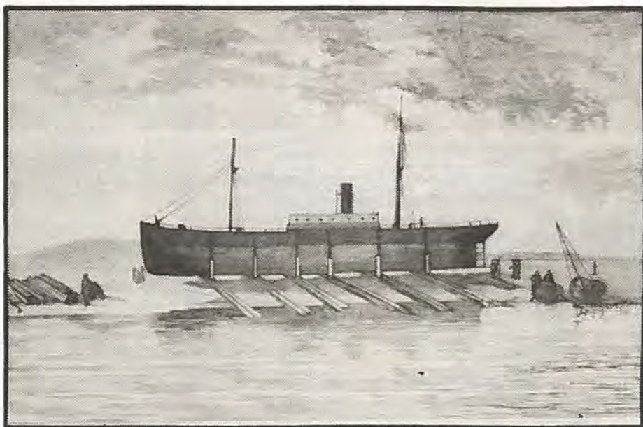
Det på Harbøre - i 1878 - strandede dampskib »Motala« løftes af Svitzer, på beddings før afløbning-en. Fra ill. Tidende, bind 20.
