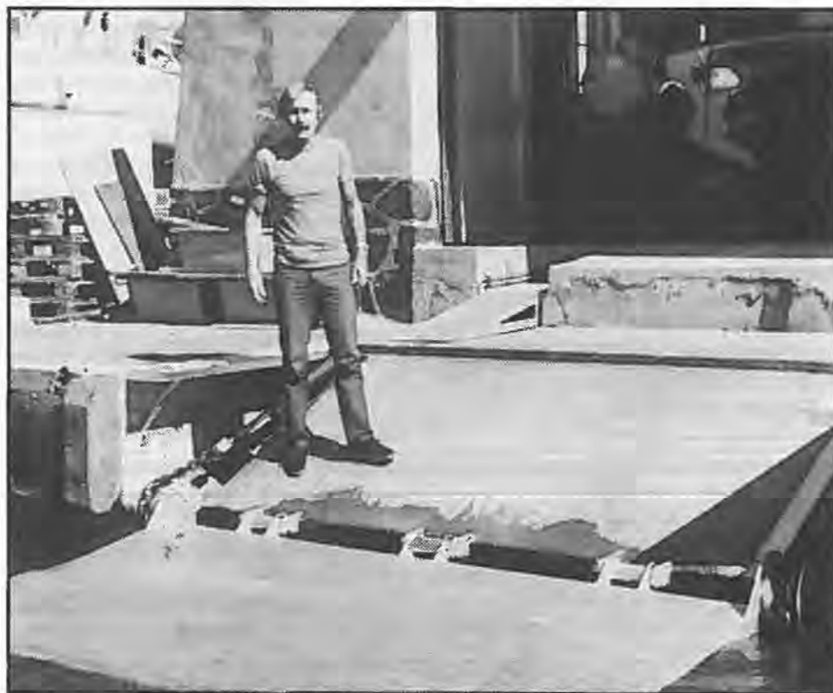
Stationsleder Axel Buchardt ved sin opfindelse - en kombineret kajplads og rampe til udsætning af stationens hjælpefartøj.
