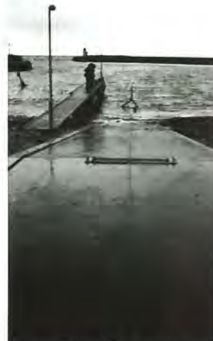
En betonsliske fører fra redningshuset ud i vandet, og ved siden af slisken er der anlagt en pælebros.
