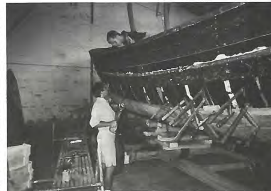
Arbejdet med genopbygning af MRB 31 skrider godt fremad, og båden ventes færdig først i det nye år.
