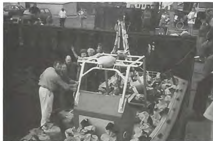
Skibets bæreevne og stabilitet blev afprøvet med sandsække.
