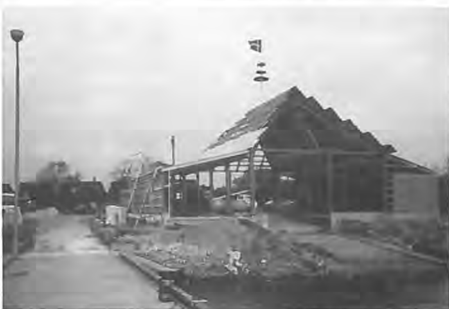
Den nye redningsstation i Gedser set fra forskellige vinkler under opførelsen.
