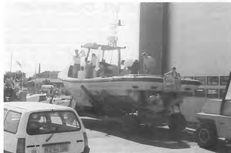
Montering af styrehus m.v. forinden stabilitetsafprøvning i havnebassinet.
