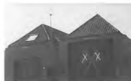
Den nye stationsbygning ved havet.
