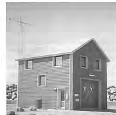
KRS Hansthølm's moderne stationbygning de har været medbestemmende i indretning af.
