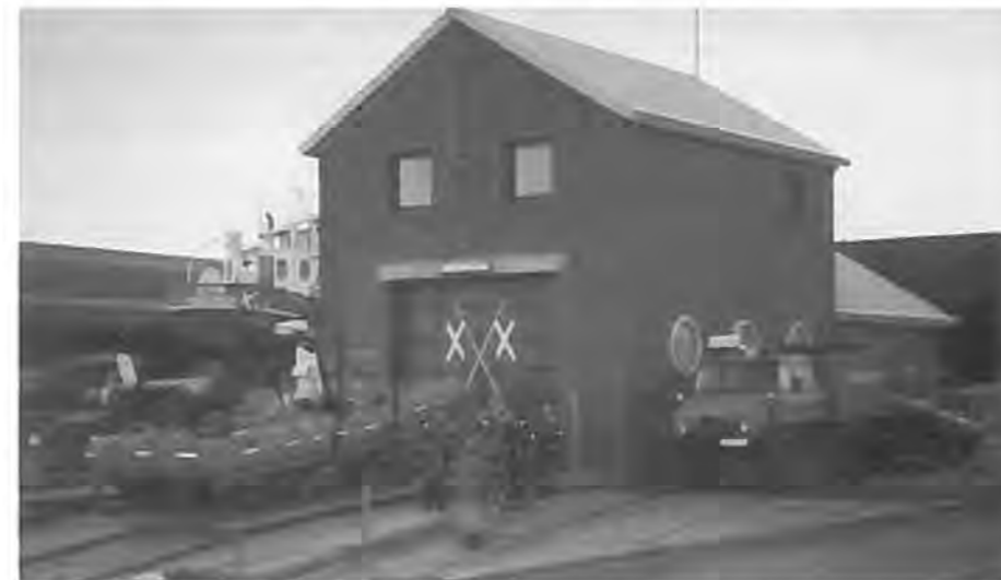
Redningsstationens nye bygning, der skal have en garage til Unimoggen bygget ved siden af stationsbygningen samt slæbestedet forlænget.
