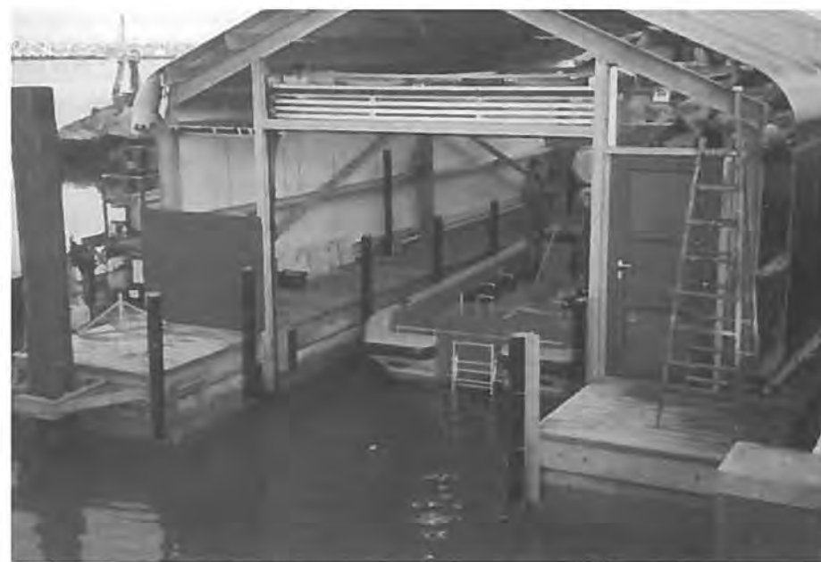
Slidsken er sænket ned under vandet og den lette redningsbåd kan sejle ind
