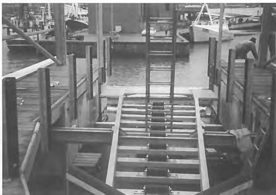
Det flydende bådhus under opbygningen. Her ses slidsken i hævet tilstand og gangbroen hvorfra man kan arbejde med fartøjet i det overdækkede hus.
