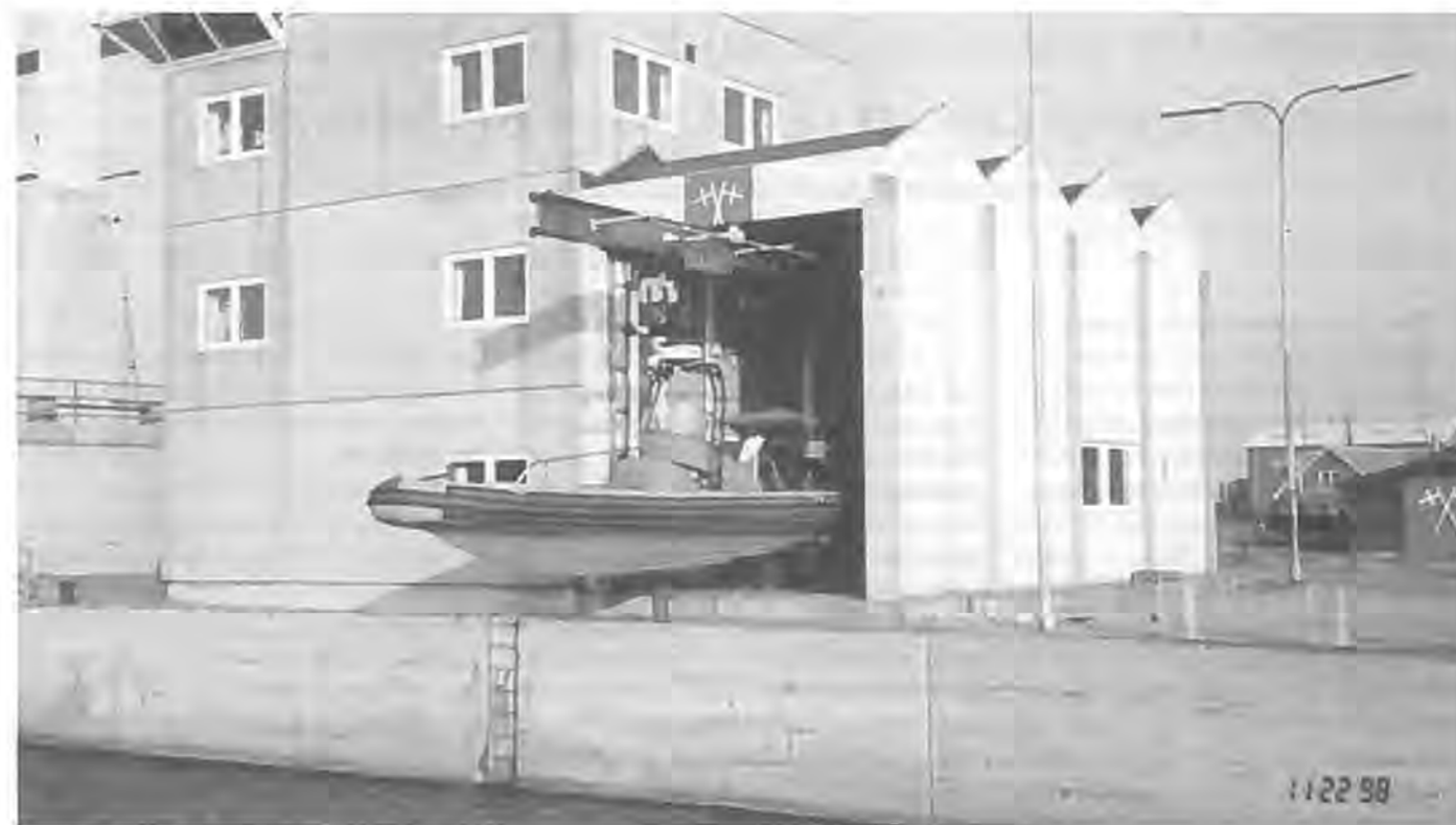
Hvide Sandes LRB sættes i vandet med skydekran udover kajkanten.
