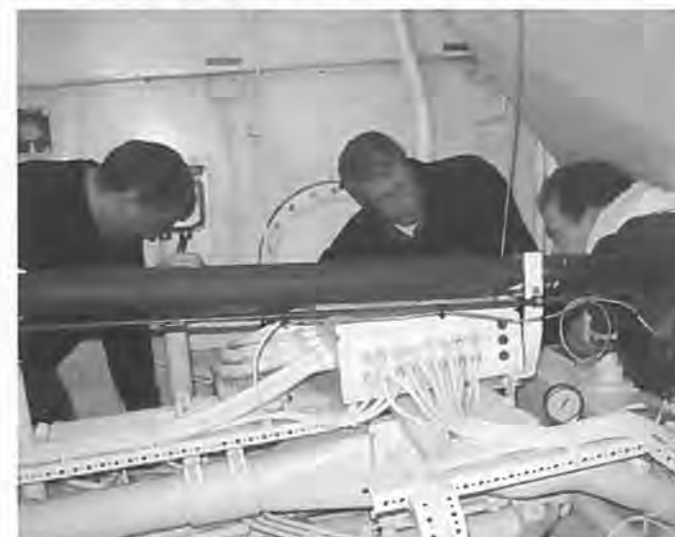
Frank, Klavs og Rico arbejder i maskinrummet om bord i L.W. DAM.
