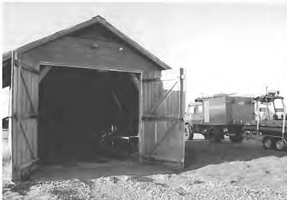
Et af Vandbygningsvæsenets gamle skure (kendt fra Olsen Banden-filmene) er garage for Agger Redningsstations Unimog. Der er ikke plads til den i den nuværende stationsbygning.
