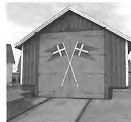
Det primitive redningshus, bygget af høvlede brædder på betonsokkel, står for en udvidelse, når stationen får en ny båd.
