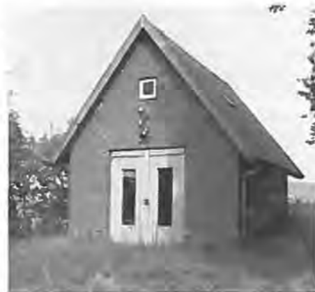
Den første og eneste raketstation på Møn blev i 1882 placeret ved opsynsmandens bolig i Ålebæk ved Borre. Foto 2008.
