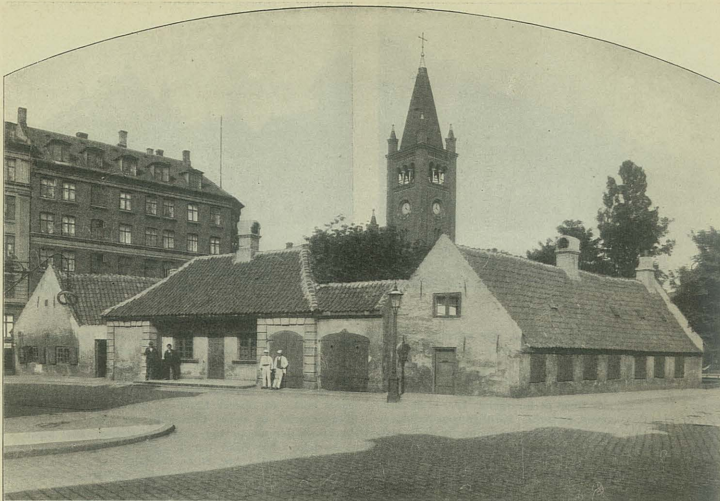
Nyboders Vagt og Kommandantskabskontorerne (tilhøjre) kort før Ombygning.
