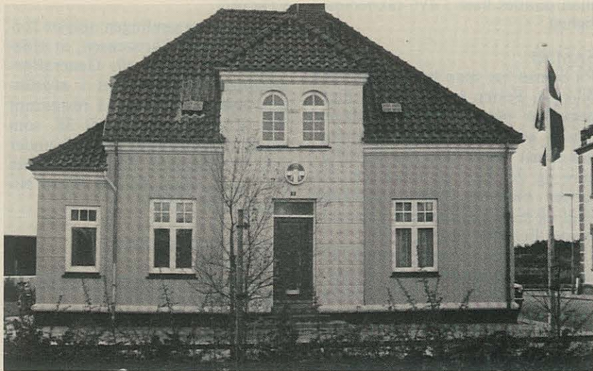
Her er Grenå-afdelingens nye Marinestue indrettet i havnens tidligere kontorbygning.
