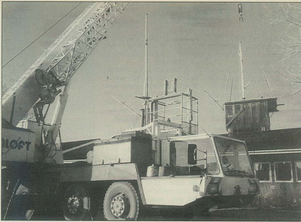
Den gamle skibsbro bliver her løftet over Aalborg Marinestues tag for at blive sat på plads.
