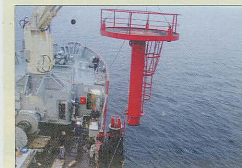
FRV inspektionsfartøj monterer fyr i søen.
