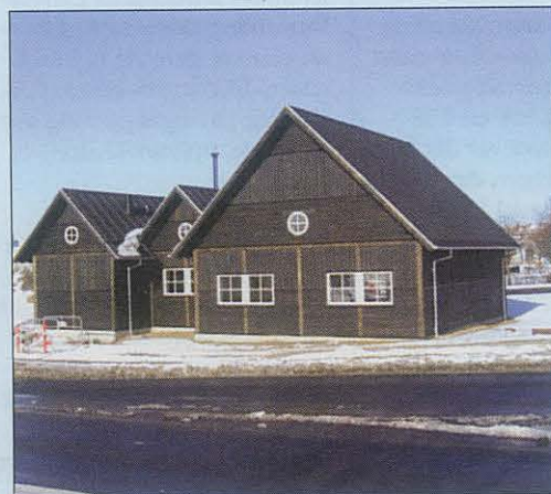
Odense Marineforenings nye Marinehus er nu under tag og klar til indretning.
