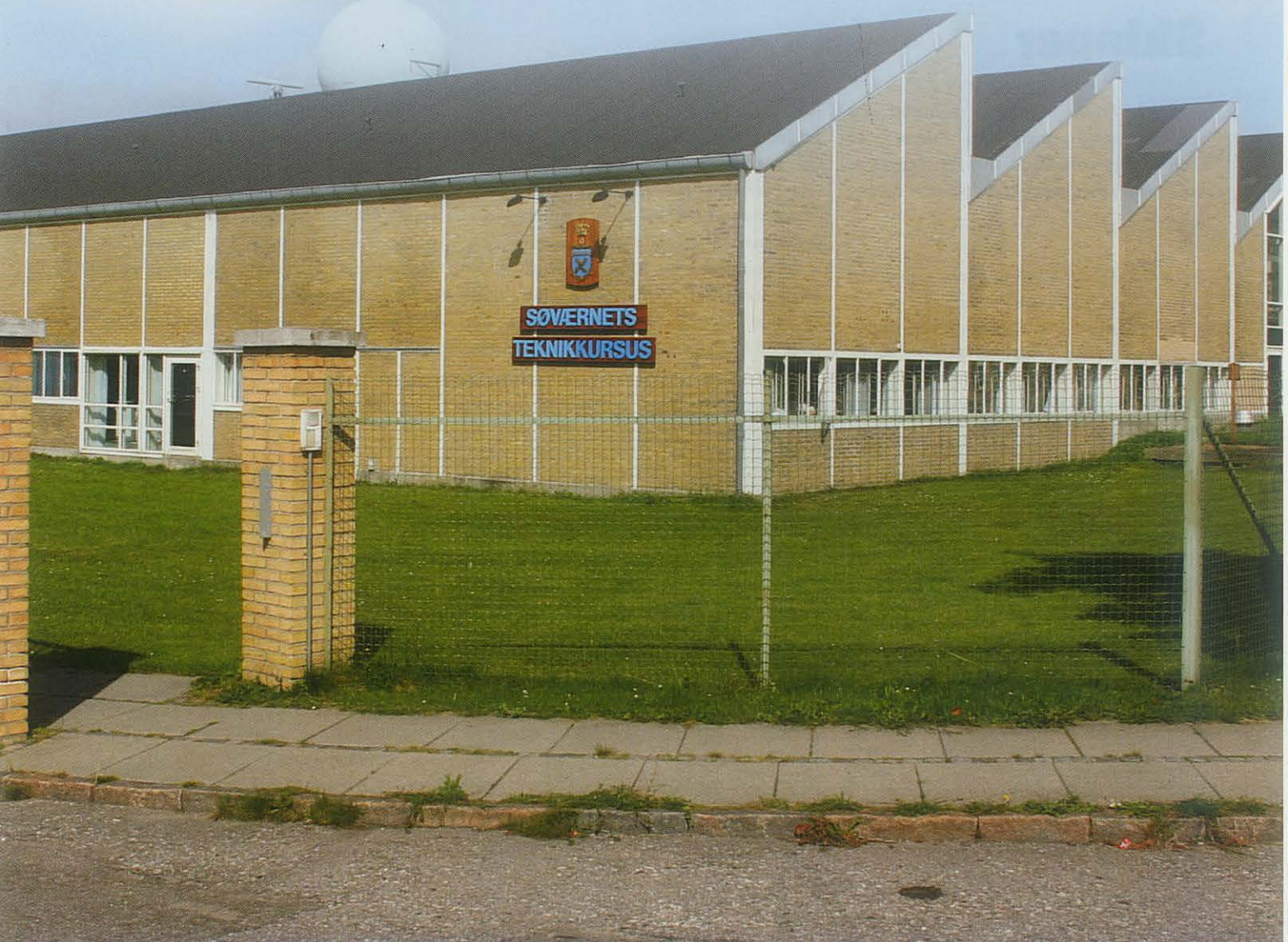
Søværnets Teknikkursus særprægede bygning, der indtil 1993 var Orlogsværftets Elektronikværksted
