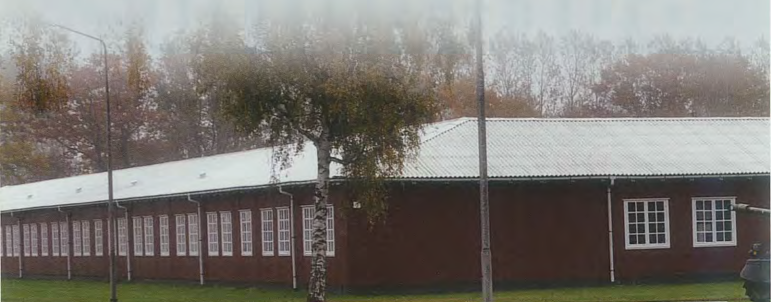
Almegård Kaserne er en smuk og velfungerende arbejdsplads.
