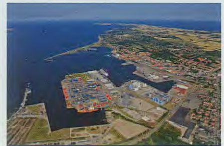
Kalundborg Havn dækker et areal på 800.000 kvadratmeter. Med udvidelseskapacitet på 600.000 kvadratmeter.
