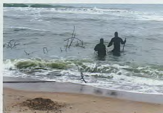
Dykkere arbejder med at montere sprængstofsører på resterne af Fjandbunkeren. Bølgerne her er den største udfordring. (Foto: Kystdirektoratet)
