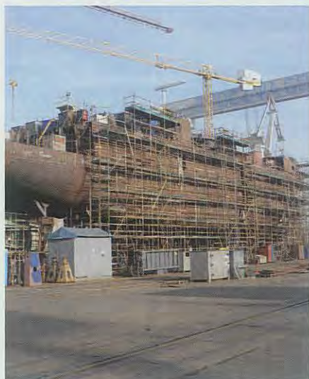
▲ LAUGE KOCH under bygning på CRIST værft i Gdynia, Polen.
