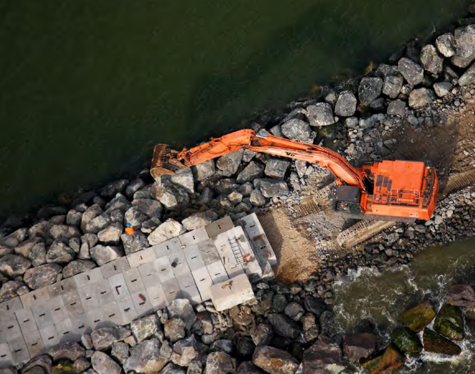
▲ VG Entreprenør A/S har anlagt nye havnemoler i Hvide Sande.
