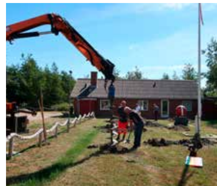
▲ Nordenergi lagde grej til, da 5 mand fra Hjørring Marineforening i juli foretog dræningsarbejde på pladsen foran Marinehuset.
