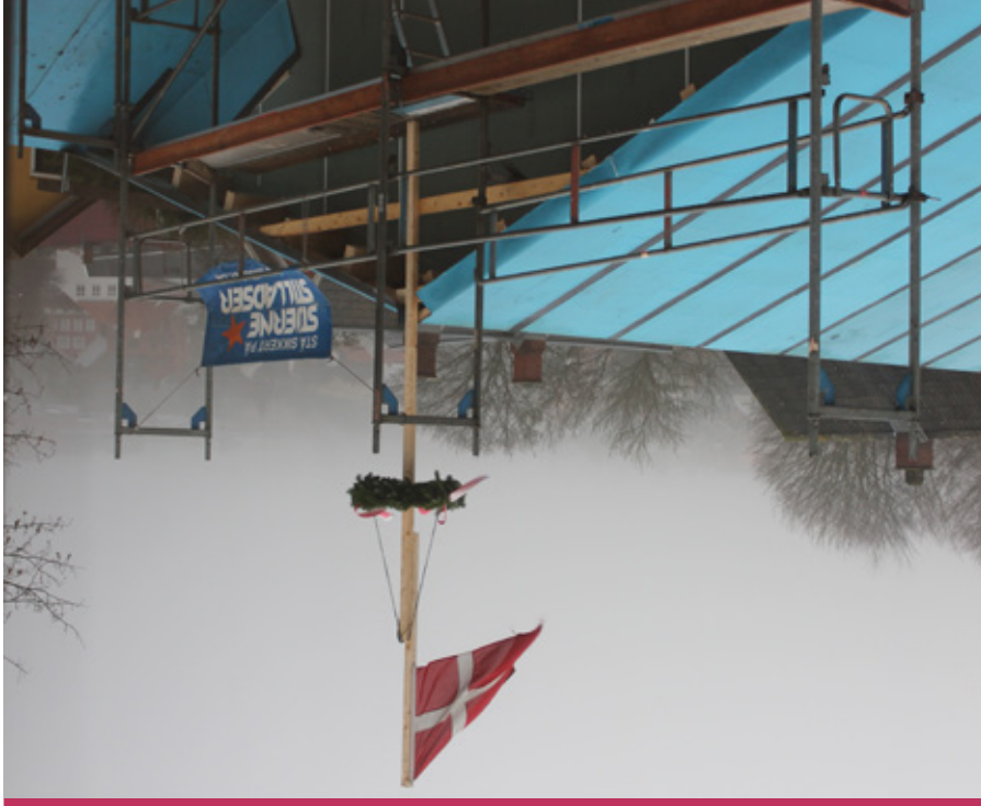
► Onsdag den 20. december 2017 var der rejsegilde på Svendborg Søfartsskoles nye værkstedbygning.
