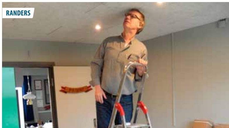
▲ Albert Pedersen monterer lyssensor til automatisk lystænding i depotrummet i Marinehuset ved Randers Fjord.
