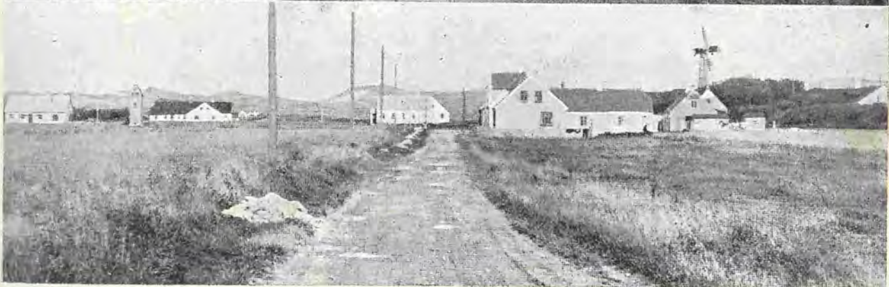
Øverst. Handsted gamle By med Signalstationen og Gavlen af Kirken i Forgrunden.
