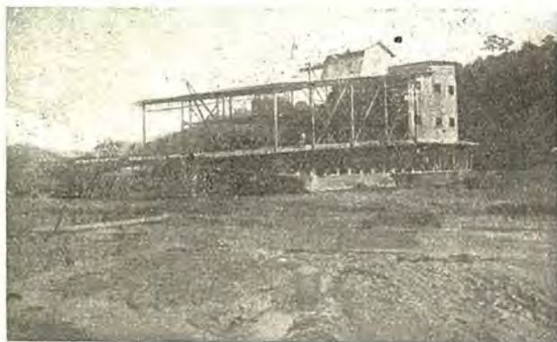
Pong Tin Minen; Gravemaskinen i Arbejde.
