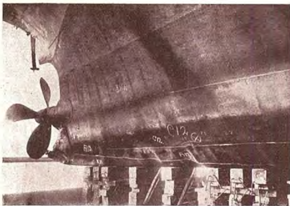
»Bellona« under Reparation: Øverst tilh. Skroget hviler paa Afstivningen. Øverst tilh. Agten for Midtskibs, Pladerne er fjærnede. Nederst tilh. Agterstævn og Ror mangler, Skruen bøjet, Bulen ses langs Kelen. Nederst tilh. Reparationsarbejdet under Bunden.
