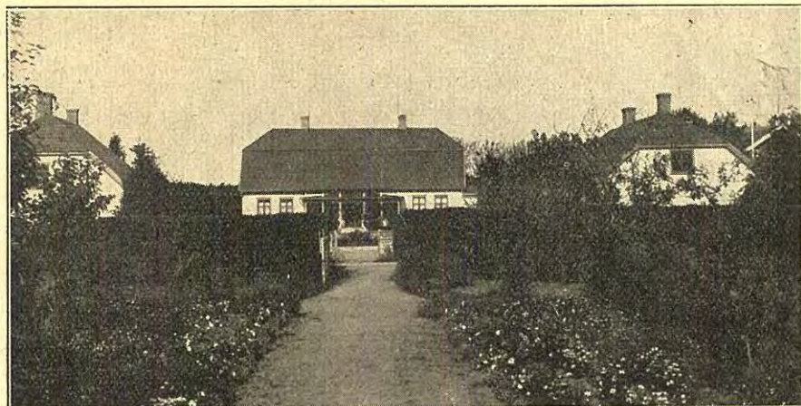
Drakenbergs Fødegård, genopbygget efter Ildsvaade.
