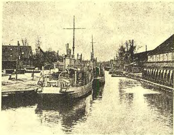
Minegraven. »Sleipner« (i Baggrunder) og Minekranerne (populært kaldet »Lopperne«).
