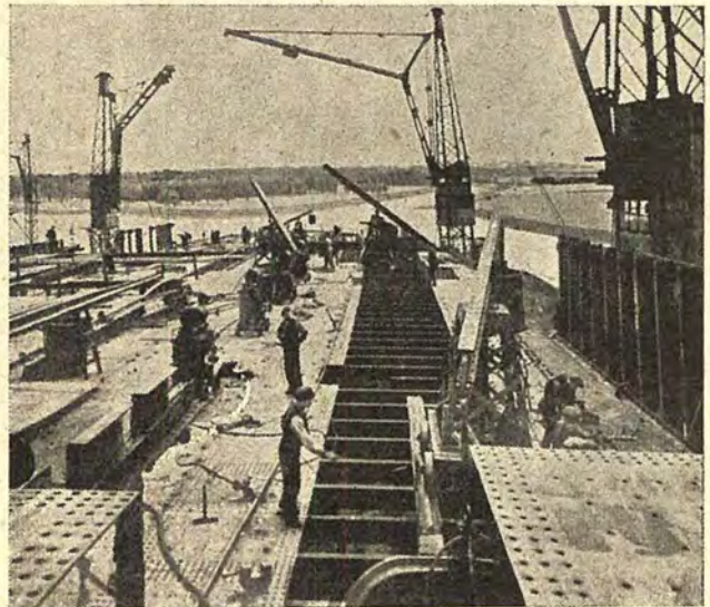
Udsigt fra Dækket over Clyden og dens Biflod Cart, som 534 skal løbe op i ved Sosætningen.
