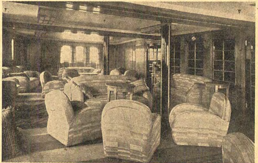
En første Klasses Salon med Sprinkler-Installation, som næppe bemærkes i Loftet.
